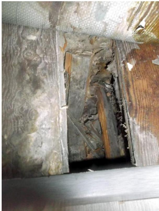
N° 20 : La mэрule est ęgalement pręsente dans les ętages : elle se trouve derrięre les panneaux isolants ou dans les planchers. Celle ci-dessus a ętę dęcouverte lorsqu'un carton de livres, collę contre la plinthe, a ętę retirę. Depuis le nettoyage, elle reste invisible, mais elle est bien pręsente.  la moindre cause de confinement, elle ręfęra surface.
